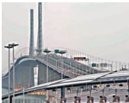
▲ 港珠澳大橋香港口岸，旅客清關服務時間由每日上午10時至晚上8時
