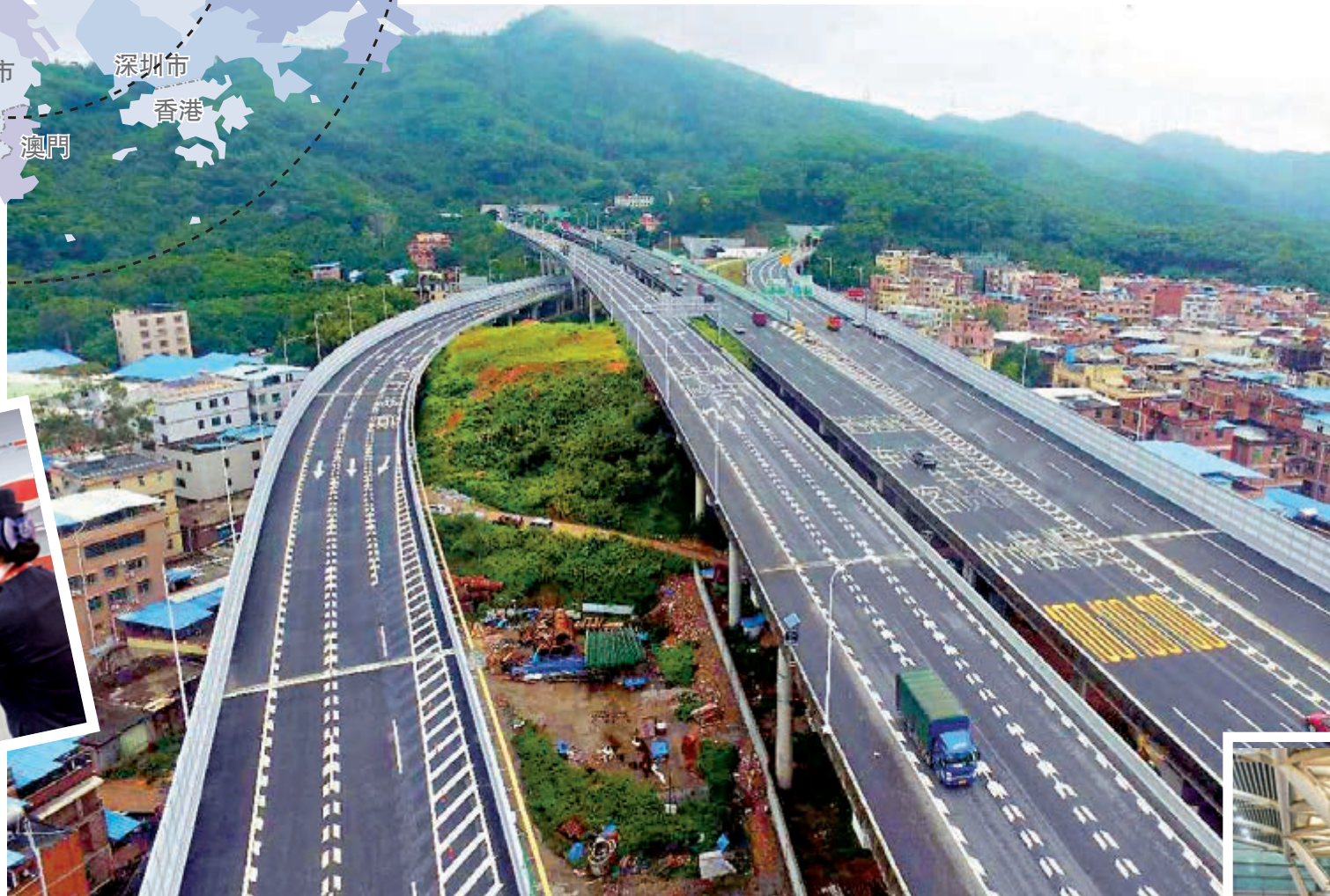
▲廣州鳳凰山隧道雙向六車道高速公路
