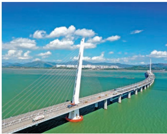
▲航拍連接深圳和香港的深圳灣大橋。
