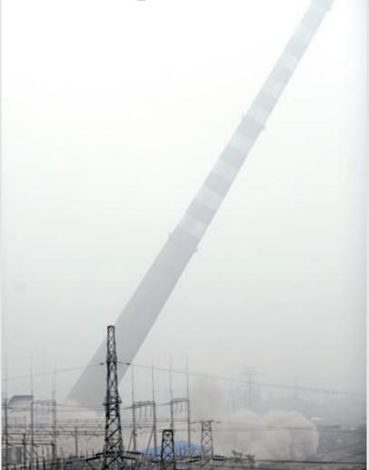
位於江西南昌發電廠內的南昌「第一高煙囪」12日成功實施爆破拆除。這個高達210米、建成於1987年的煙囪，是目前江西省爆破拆除的最高建築物
