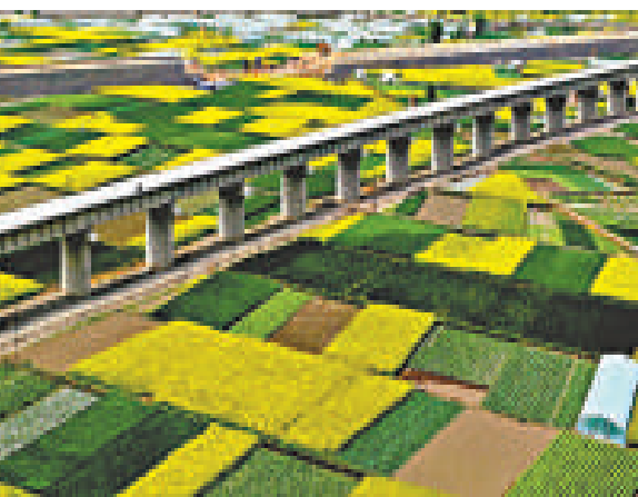
▲建設中的蘭渝鐵路兩水段 冉創昌攝
