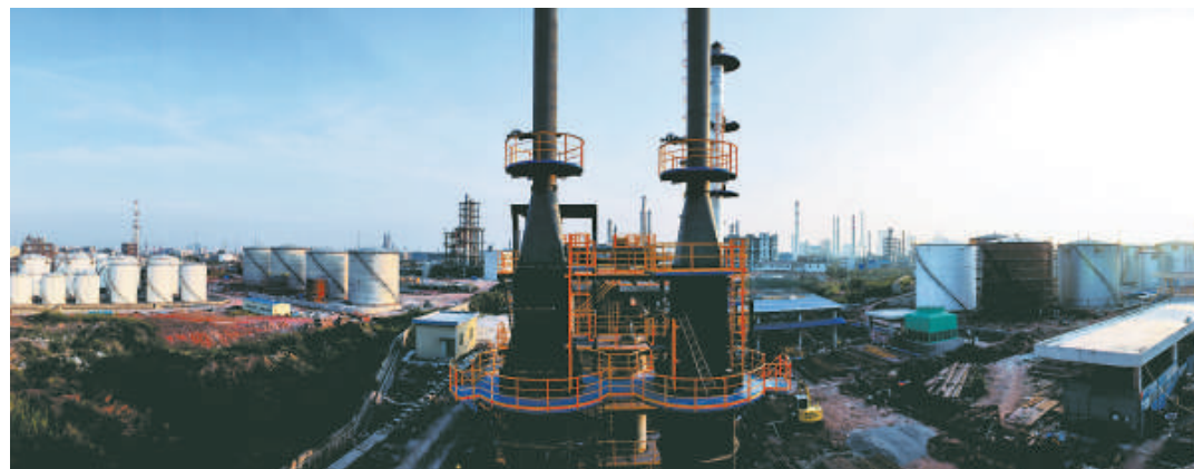
華粵華信在建工地
