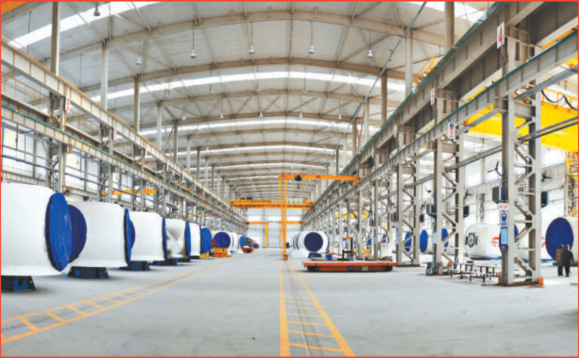
▲兵裝集團天威新能源（長春）產業園廠區內景
