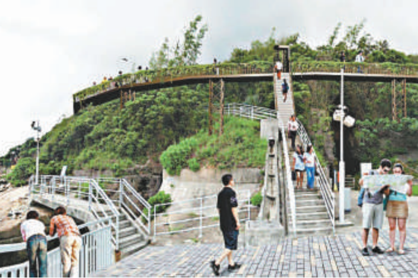
▲筲箕灣段沿海防博物館山坡研興建長約六百米的高架天梯
