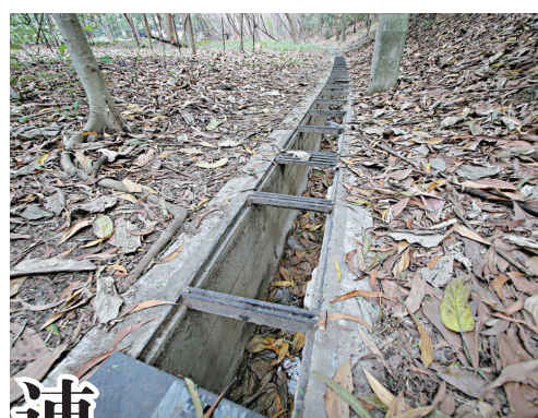
▲連翔道五十個坑渠蓋被偷
