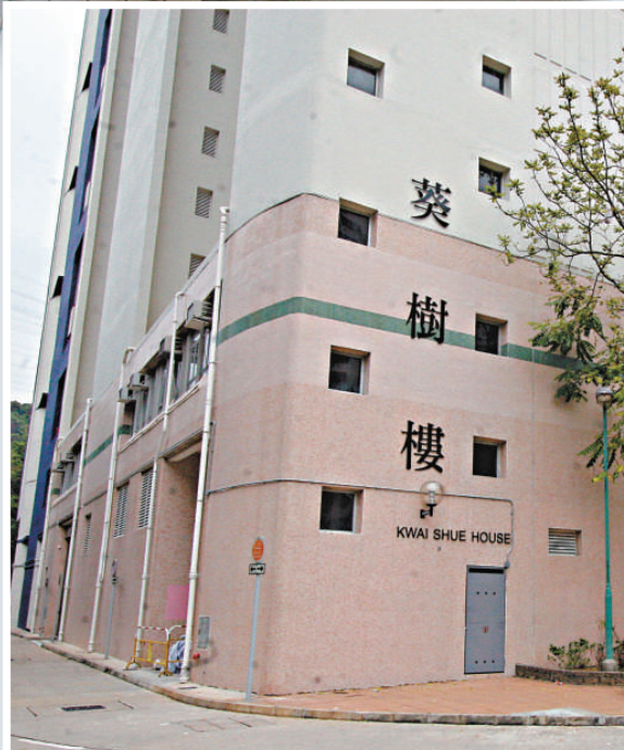
▲梨木樹邨少年墮樓事發現場葵樹樓
