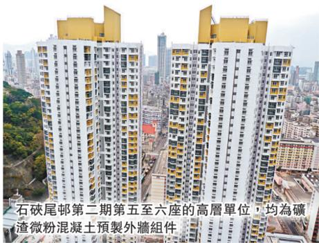
石硤尾邨第二期第五至六座的高層單位，均為礦渣微粉混凝土預製外牆組件。
