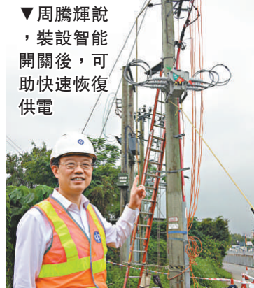
▼周騰輝說，裝設智能開關後，可助快速恢復供電
