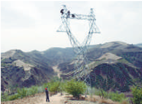
▲電力工人在延安農村安裝大型電塔 本報攝
