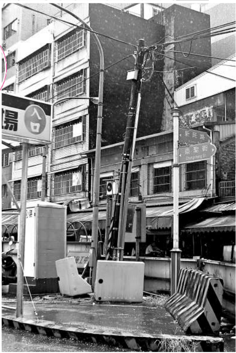
►當天在宜蘭新民路與崇聖街交匯口拍攝的一根因地震發生傾斜的電線杆 新華社
