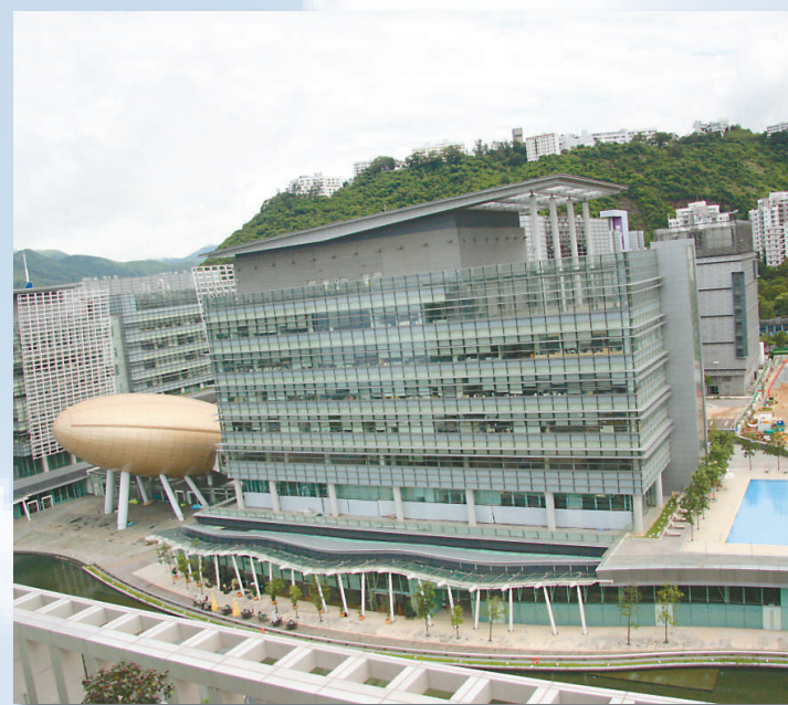
從綠景園俯瞰科學園，右爲正在施工的第三期，預期2016年全面落成，整個科學園有近500間科技公司進駐
