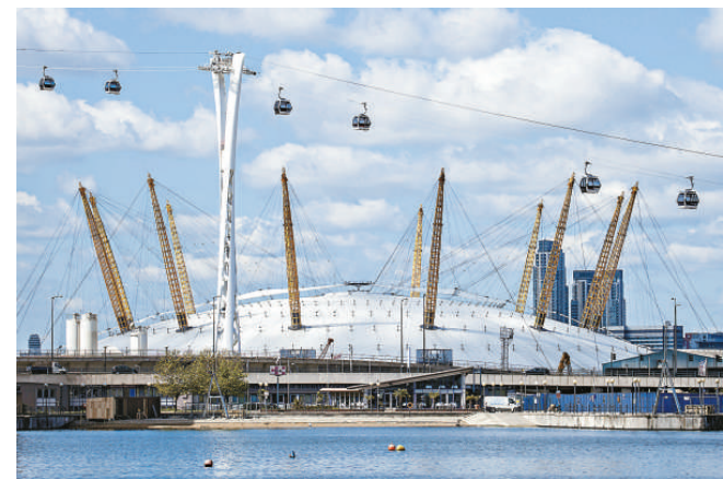
▲橫跨泰晤士河的奧運纜車工程已大致完成
