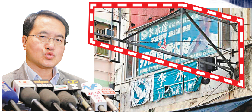
▲李永達議員辦事處大廈外牆涉嫌有違規安裝的燈箱、射燈和支架
