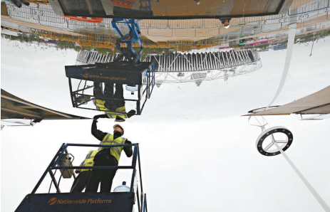
◀倫敦奧運主場館工程進度落後，迄今仍未竣工
