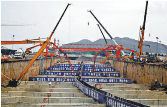
▲澳大橫琴校區隧道「海中段」建設現場 本報攝
