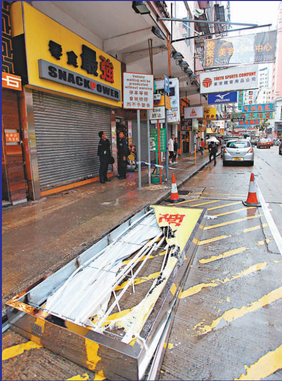
▲西洋菜南街有大型招牌飛墮，橫亘路上
