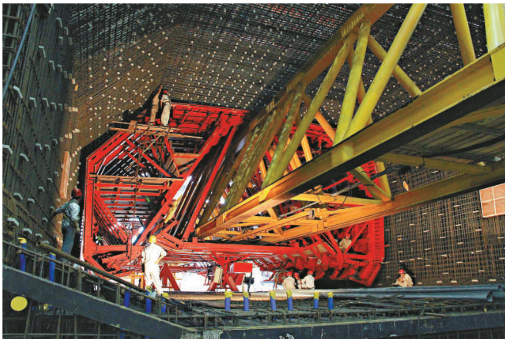
▲港珠澳大橋首個沉管節段內模復位，展開混凝土澆築 本報攝
