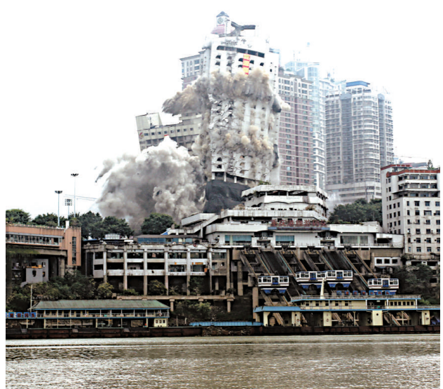
▲30日，重慶港客運大樓和三峽賓館被爆破拆除，瞬間化為瓦礫。陳曉彬攝
