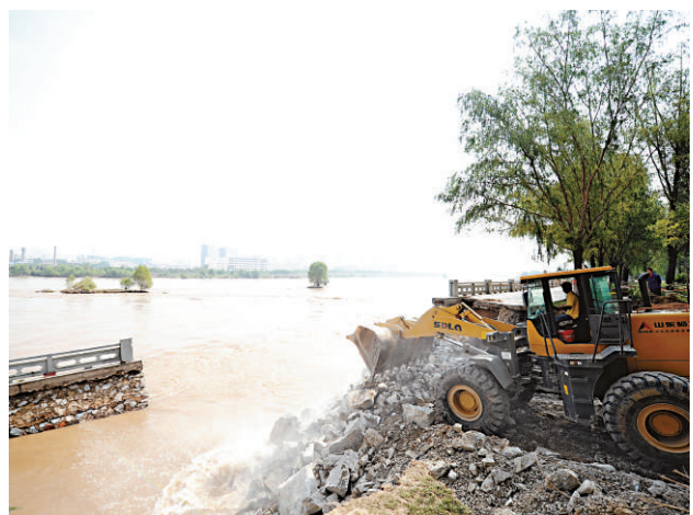
▲29日，蘭州市南濱河七里河黃河秀川段堤防垮塌。中新社
