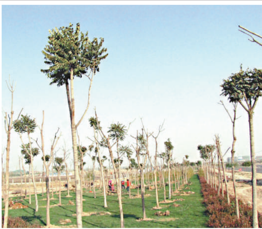
▲正在建設的蘭州新區綠化區
