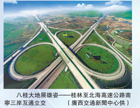
八桂大地展雄姿——桂林至北海高速公路南寧三岸互通立交 (廣西交通新聞中心供)
