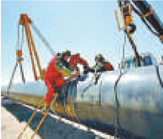
▲土庫曼對華供天然氣累計已逾300億立方米。圖為工作人員在安裝天然氣管道 網絡圖片
