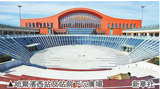
▲哈爾濱西站及站前下沉廣場
