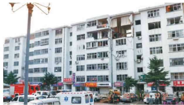
▲發生石油氣爆炸的威海民居，部分外牆被炸穿
