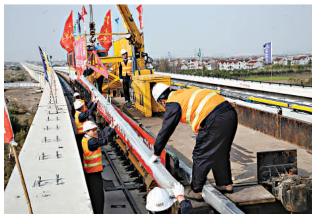
▲20日，工作人員在上海軌道交通16號線野生動物園站施工。當日，上海軌道交通16號線接觸軌工程具備安裝條件，安裝調試工作正式啟動。據了解，16號線是國內首條設計時速為120公里、採用接觸軌（三軌）受電方式的軌道交通，建成後將對促進浦東經濟發展發揮重要作用 新華社
