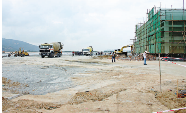
▲粵澳合作中醫藥科技產業園首期斥資6億元，正開展園區內的場地平整和吹填施工 方俊明攝
