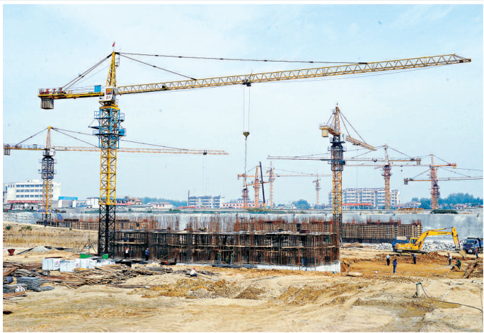
▲山東省棗莊市棚戶區改造帶動了城鎮居民就業，並促進了城鎮化的順利推進。圖為建設中的棗莊市棚戶區改造工程 新華社
