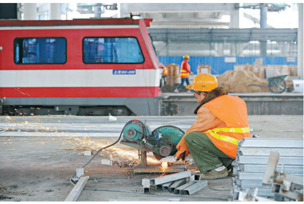
▲貴州正全力建設綜合交通網絡。圖為中鐵八局的建設者們在貴陽火車站技施施工現場工作 新華社
