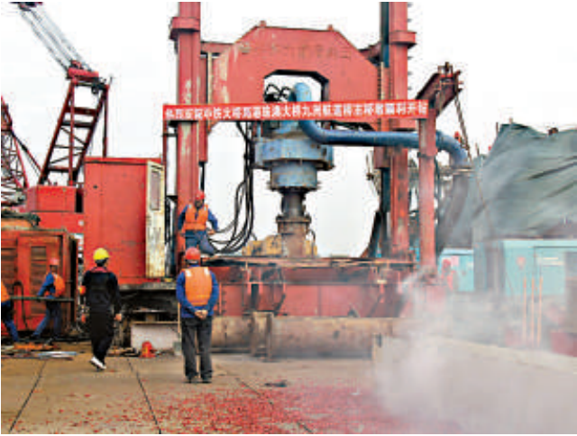
▲港珠澳大橋首批沉管管節一次艤裝施工逐步推進，即將浮運、沉放作業 本報記者方俊明攝
