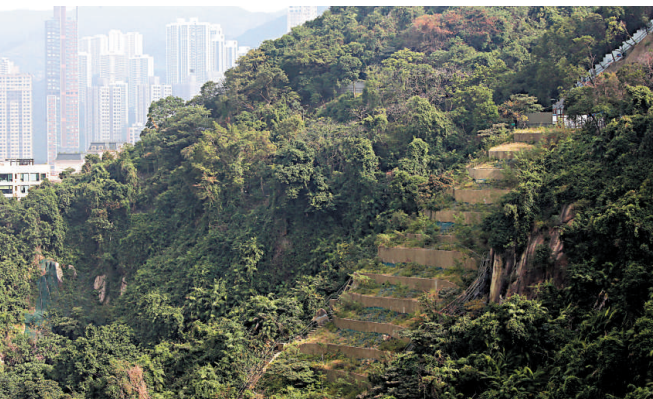
▲灣仔半山寶雲道是一個美化山泥傾瀉殘痕的成功例子，沿斜坡表面築有多重台階，讓附近山坡上的植物品種自然散播 本報記者蔡文豪攝
