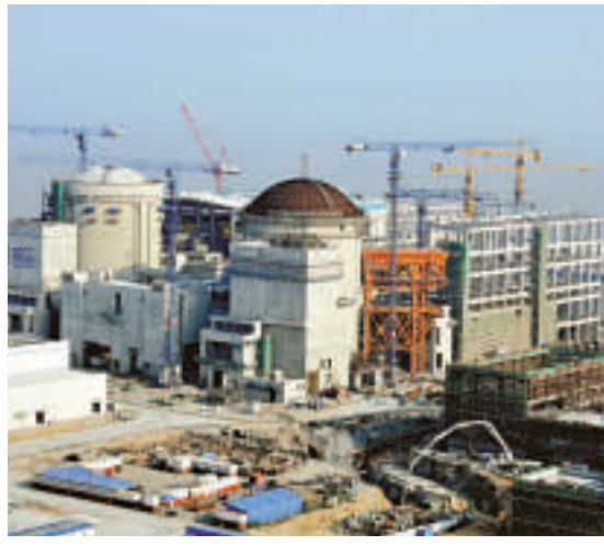
▲寧德核電項目建成後年發電量約300億度。圖爲興建中的福建寧德核電站 資料圖片
