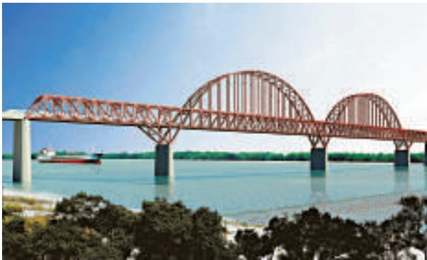
▲2012年12月23日，揭陽榕江特大橋鋼桁樑柔性拱架成功合龍，有望在春節後鋪軌
