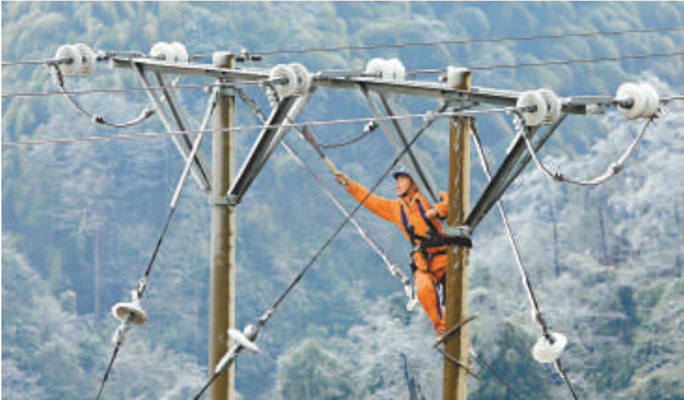
►6日，在廣西柳州市融安縣大坡鄉，電力工人在清除電力線路上的覆冰
