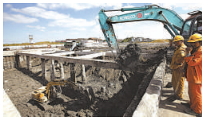
▲在浦東新區的上海迪士尼項目施工現場，工程車輛開挖軌道交通迪士尼樂園站的地下空間 資料圖片
