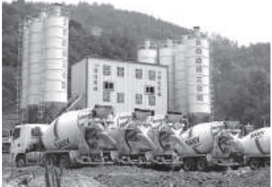
▲建設中的龍瑞高速公路 德宏州交通局供圖
