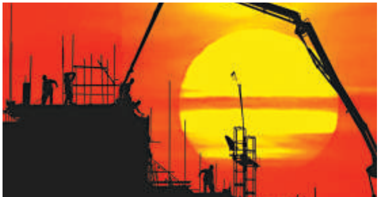
▲基礎設施建設如火如荼
