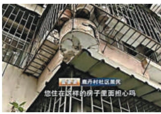
▲受海沙侵蝕，深圳鹿丹村社區24棟房屋出現多處裂縫 網絡圖片
