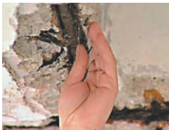
▲部分鋼筋雖然還貼在房屋上，但只要輕輕一觸，鋼筋即應聲而斷 網絡圖片
