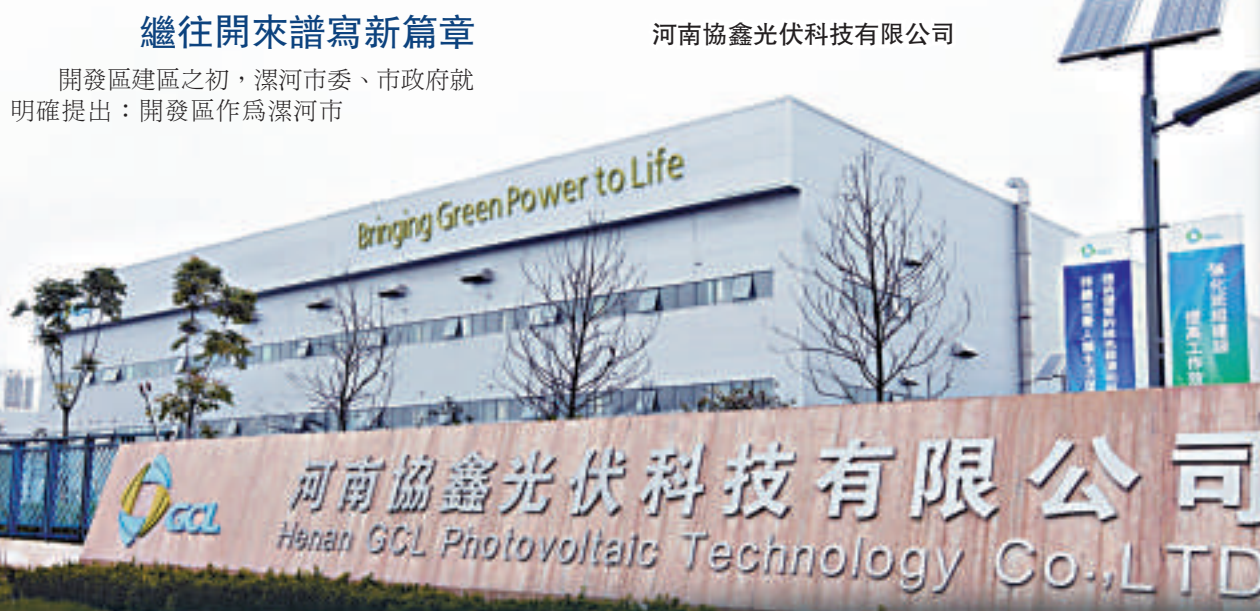
河南協鑫光伏科技有限公司
