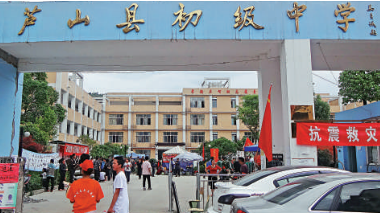
▲四川省政府派出專家到蘆山縣初級中學進行震損鑑定，初步評估建築物的結構沒有大問題，並未定為危房
