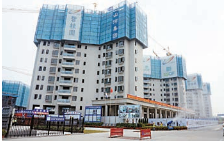
▲「SSGF」工地幾乎看不到露天擺放的建築材料 大公報記者方俊明攝
