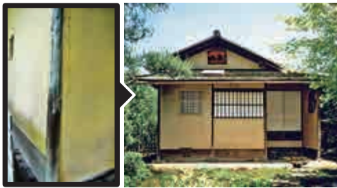
◀「侍庵」外牆出現長約兩米的裂縫 網上圖片
