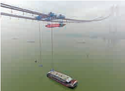
▲虎門二橋工程建設進入到主樑架設階段，為2019年上半年建成通車打下基礎 中新社
