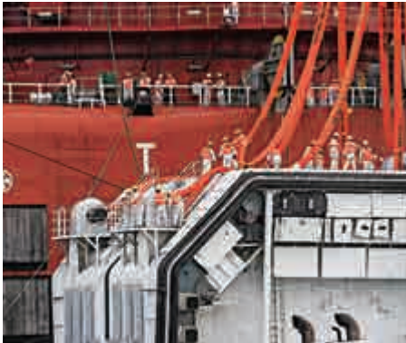
▲港珠澳大橋擁有世界上最長的沉管海底隧道，圖為工作人員在港珠澳大橋沉管隧道最終接頭上安裝吊帶 資料圖片
