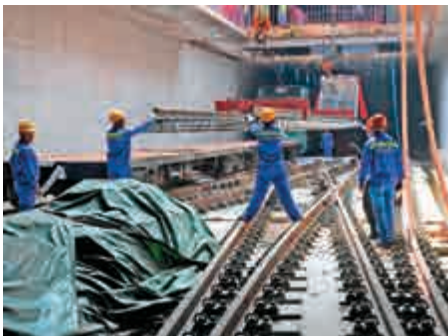
▲深圳地鐵媽灣站鋪軌基地的建設工人正在進行吊軌作業。資料圖片
