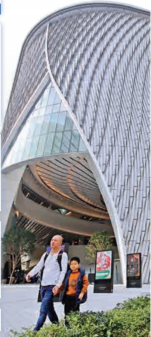
「離地」劇院 ▲大劇院離地30米的高懸浮式架空設計，可阻隔震動噪音
