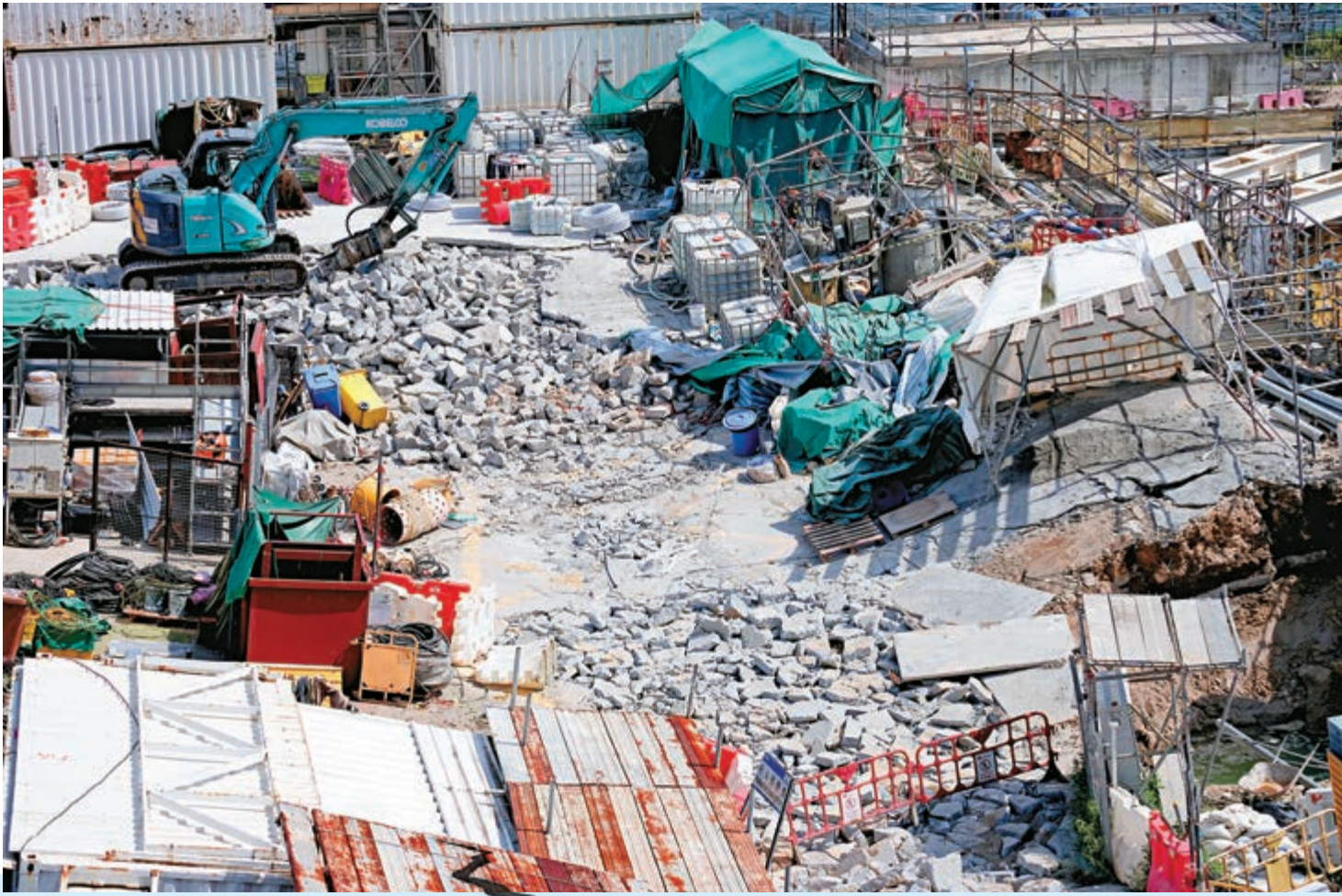
▲西九文化區地盤曾出現地陷及裂縫的位置，表層混凝土已經被打碎重整
