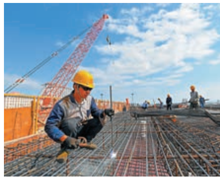
工人在「一帶一路」建設重點工程新建福廈鐵路施工 新華社
