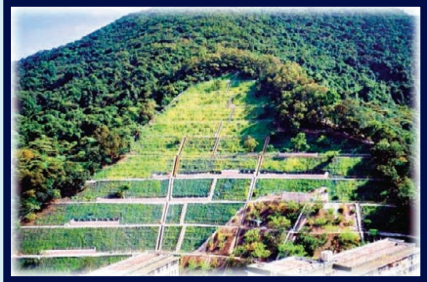
▲土力處經常展開斜坡鞏固工程，藉此防治山泥傾瀉
